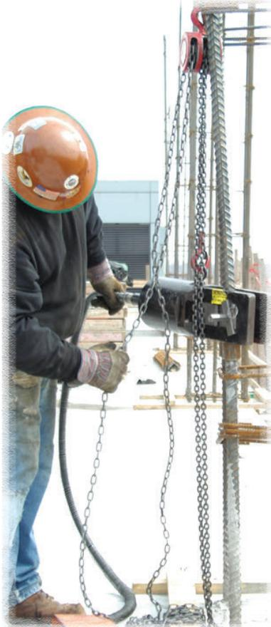
Los empalmes prensado en frío BarGrip XL consisten en camisas de acero sin costura que se deslizan sobre los extremos de las barras de refuerzo. Se estampan en el perfil de la barra de refuerzo para producir un enclavamiento mecánico.
