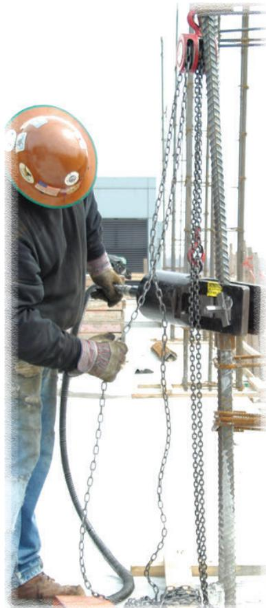
**Les manchons d'épaisseur pressés à froid BarGrip** sont constitués de manchons en acier non soudés qui glissent sur les extrémités des barres d'armature. Ils se déforment sur le profil de la barre de manière à réaliser un verrouillage mécanique.
